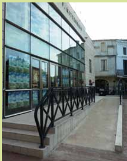
Pose du garde-corps de la rampe d'accès à l'Espace François Mitterrand
