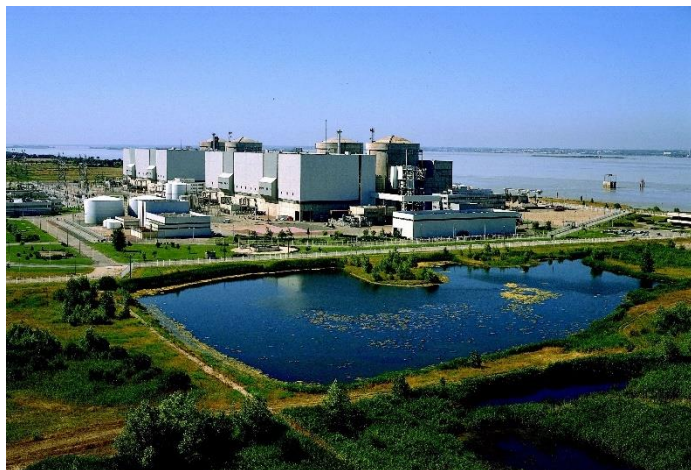
Centrale nucléaire du Blayais sur l'estuaire @EDF
